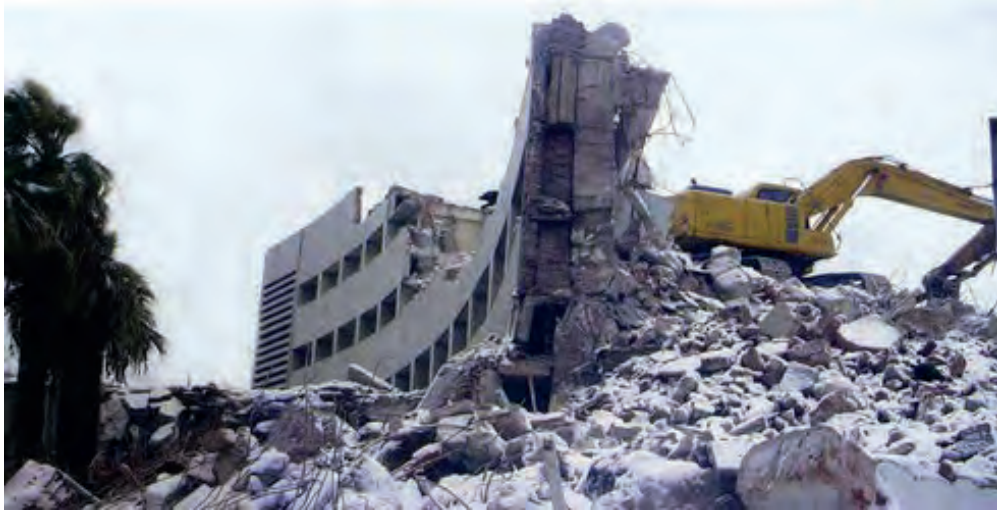
Resim 2. Balıkesir Kervansaray Otelı yıkımı, 2006, (Mimarizm).
