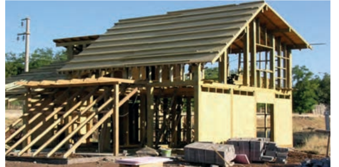
Resim 13. Diyarbakır Güneş Evi ahşap strüktür.
