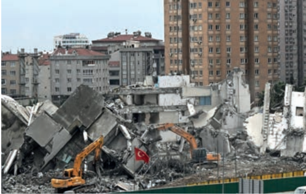
Resim 2. Tercüman Binası yıkımı sırasında (AA).
