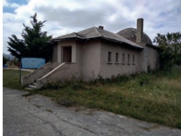
Resim 8. Enstitü döneminde inşa edilmiş olan, yığma taş duvarlar üzerinde yükselen betonarme kubbeye sahip hamam yapısı.
