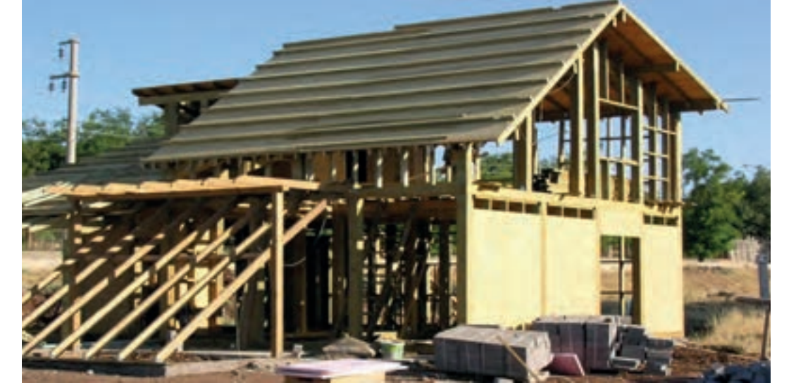
Resim 13. Diyarbakır Güneş Evi ahşap strüktür.
