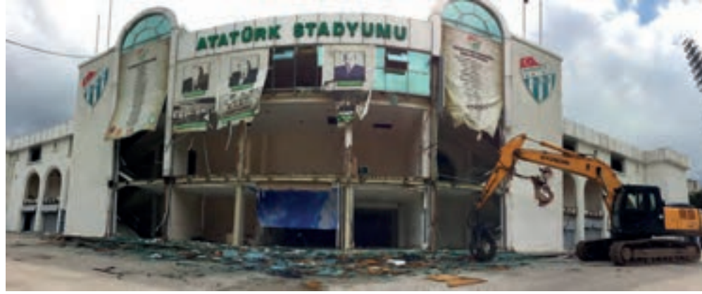
Resim 3. Bursa Atatürk Stadyumunun yıkımı, 2020.
