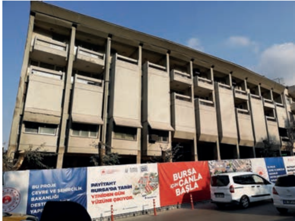
Resim 4. Bursa Merkez Bankasının yıkımdan hemen önce, 2020.
