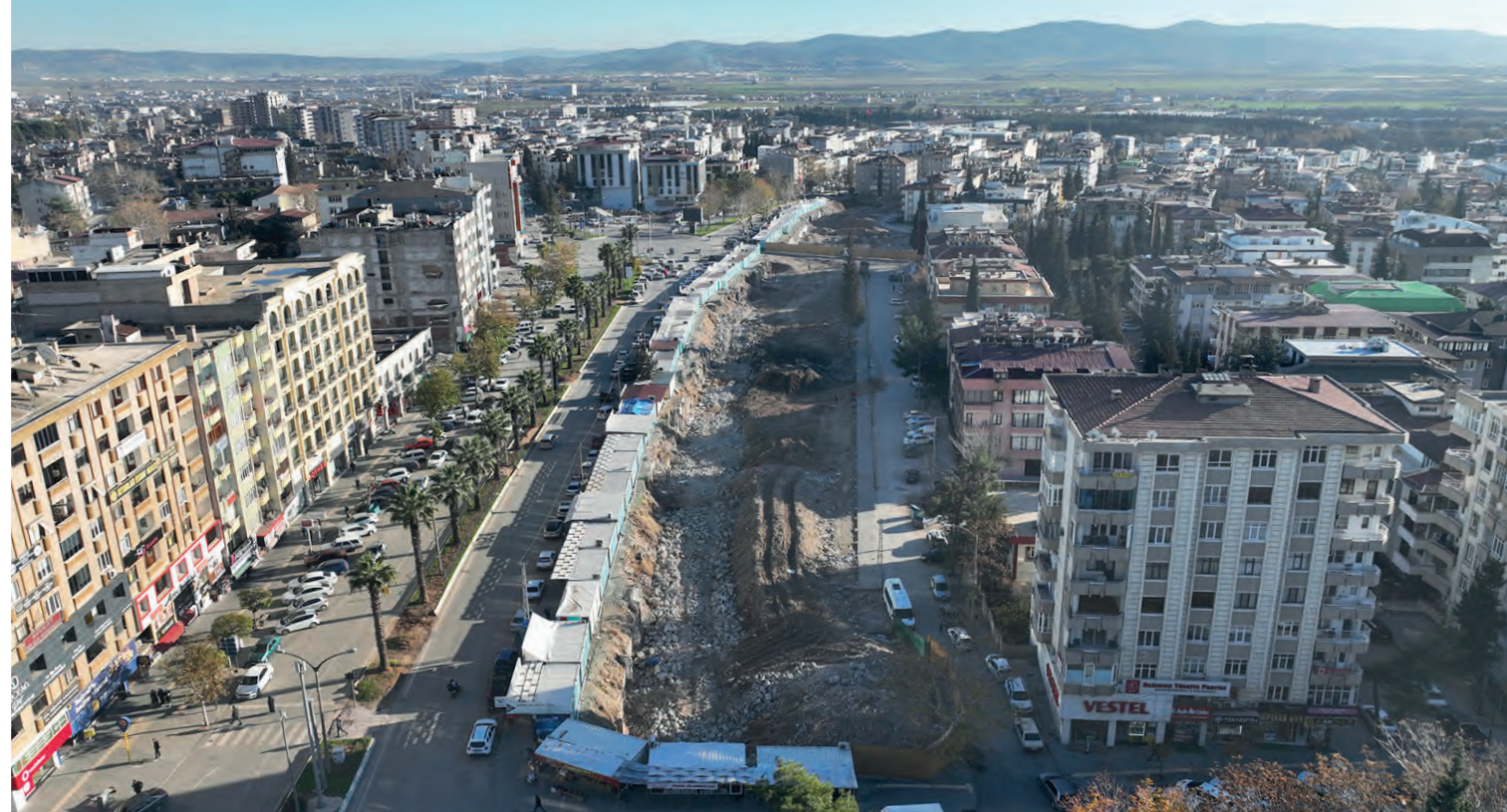
Resim 1. Şantiye halindeki Kahramanmaraş.
