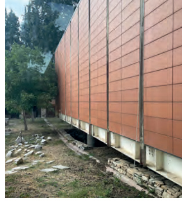
Resim 20. Geçiş mekanından dışarıya bakış (İmran Satış Atar, 2023).
