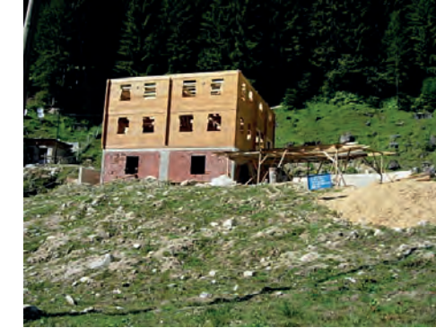
Yaylada apartman inşaatı.
