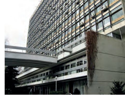
Resim 4. Güney cephesinde çıplak beton detaylar, çörtlen ve köprü, 2011 (Zafer Akay).
