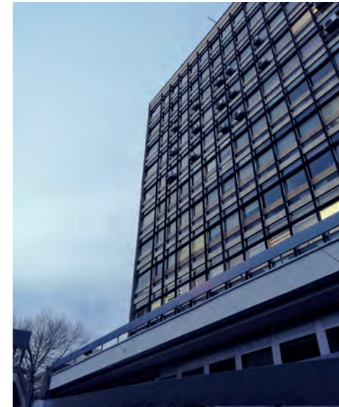
Resim 3. Güney cephe detayları, 2017 (imo.org.tr).
