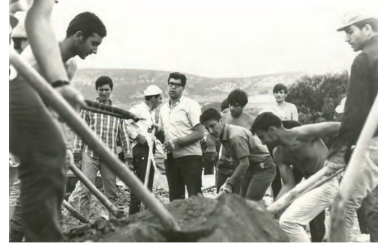
Resim 5. Hep beraber beton karıyoruz.
