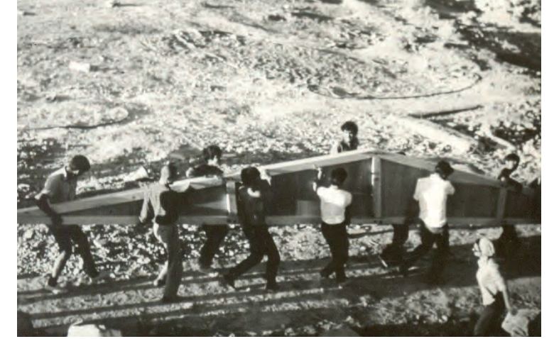
Resim 6. Çatı makasını hep birlikte taşıyoruz.
