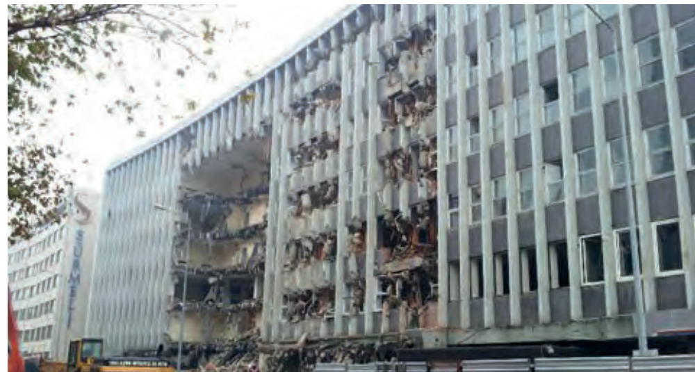
Resim 2 Yıkım Aşamasında Etibank Binası ( http://www.yapi.com.tr/haberler/cumhuriyet-donemi-ornegi-yapilar-birer-birer-yikiliyor_104100.html )
