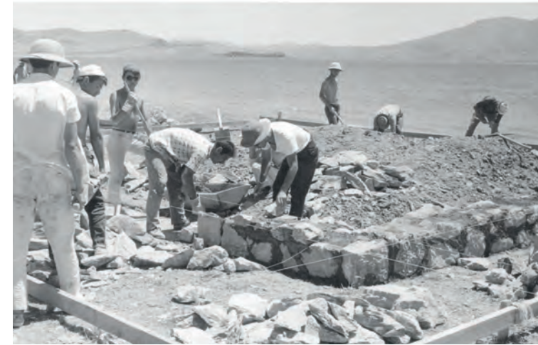
Resim 13. Gazino Binası-Güneyköy/Elazığ-1966 (www.metuarchers.com)
