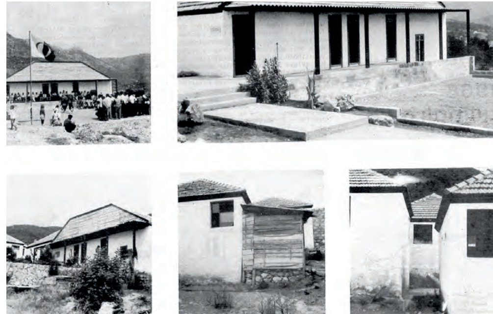
Resim 2. Ortaokul Binası-Gilindere/İçel-1968 (www.metuarchers.com)
