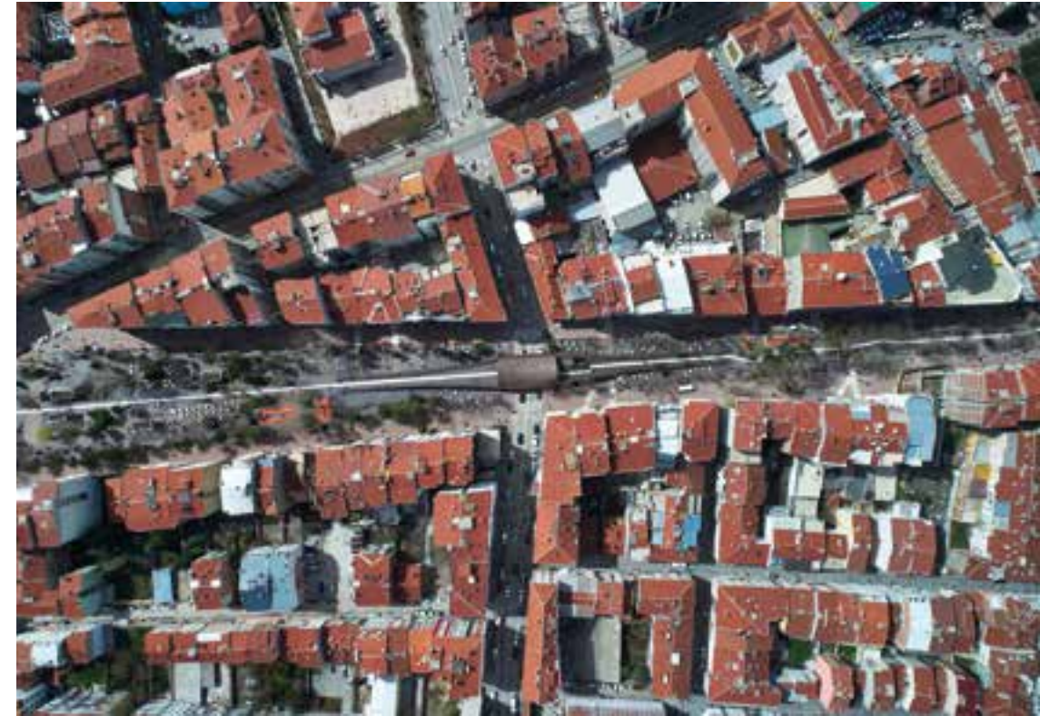
Hamamıyolu Urban Deck
