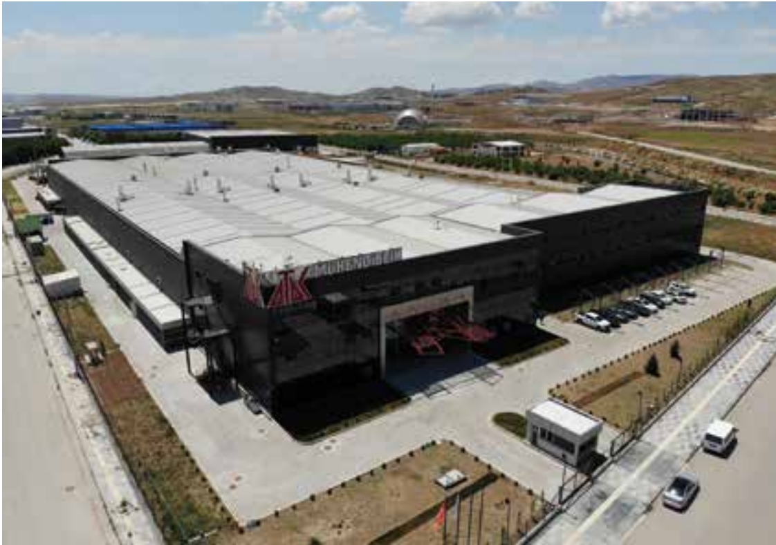
Ankara Atak Mühendislik Fabrika ve Ofis Binası
