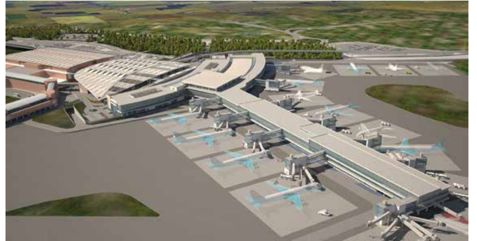
Mısır-Kahire Havaalanı TB2 Terminal Binası
