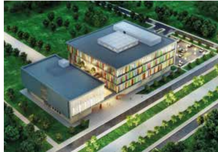
Erzincan Binali Yıldırım Üniversitesi Kütüphane ve Müze Binası, 2019
