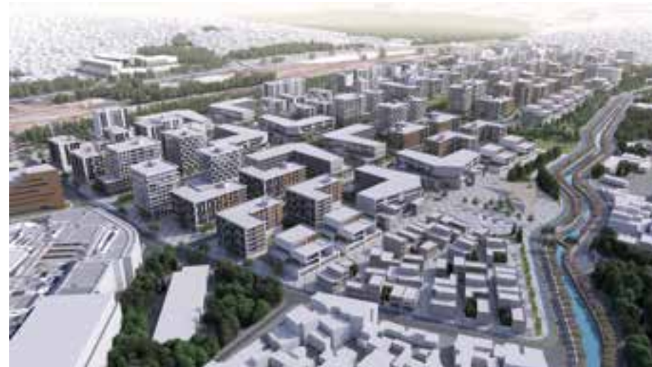
Gaziantep Tüfekçi Yusuf Kentsel Dönüşüm Projesi
