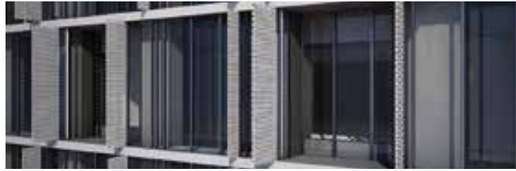
Sayer Şirketler Grubu Genel Merkez Binası Dış Cephe ve Kütile Yenileme Projesi, 2012
