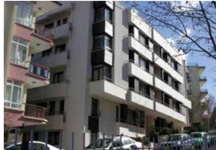
Özerkliğ Apartmanı, Çankaya, Ankara, 2003
