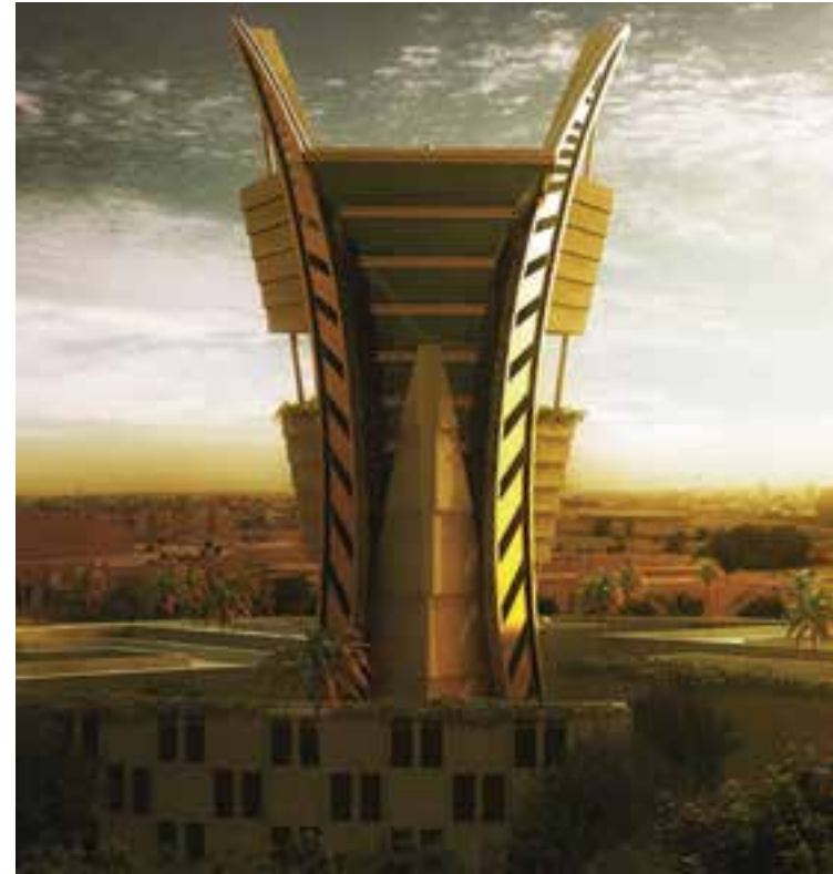
Libya Tripoli Savunma Bakanlığı Binası
