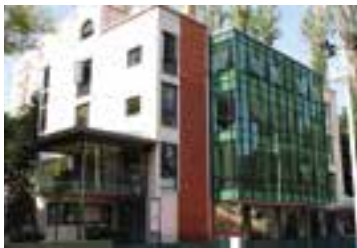
Kavaklıdere Sosyal Kulübü Restoran ve Cephe Yenilemesi, 2013
