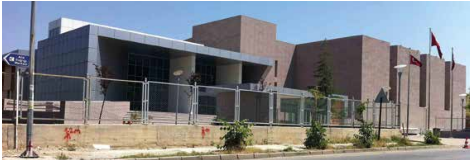
Dışişleri Arşiv Binası
