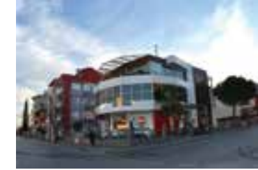
Yavaşçalar Ofis Binası
