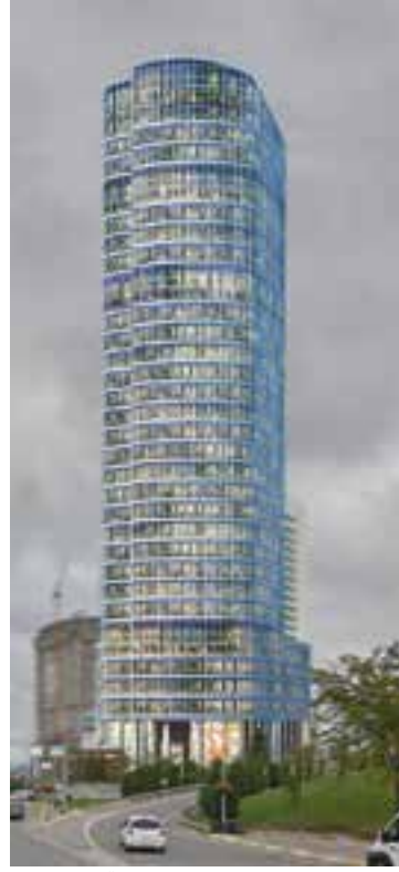
Türk Telekom Ümraniye Genel Müdürlük Binası-Ofis
