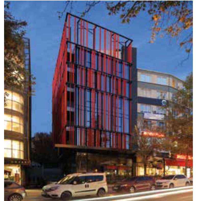
TEV Ofis Binası
