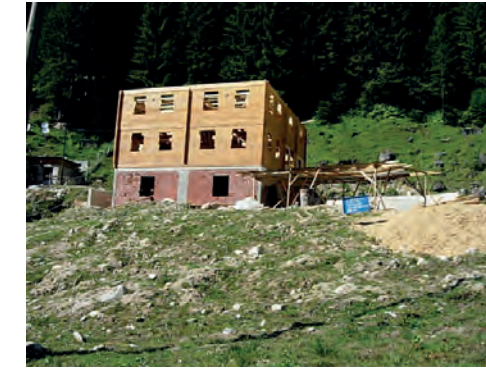
Yaylada apartman inşaatı.
