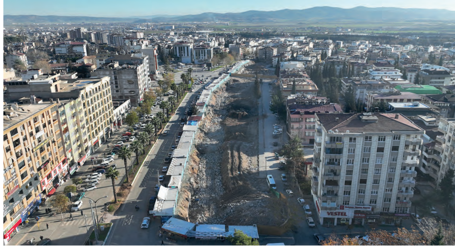
Resim 1. Şantiye halindeki Kahramanmaraş.
