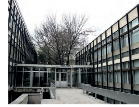
Resim 5. Kuzeydeki alçak blok ile büro bloğu arasındaki avlu, 2011 (Zafer Akay).
