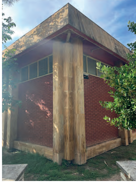
Resim 8. Taşıyıcı sistem ve cephe malzemelerine ilişkin bir detay (İmran Satış Atar, 2023).
